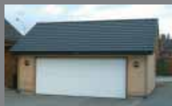
Stålport med panelstruktur.
